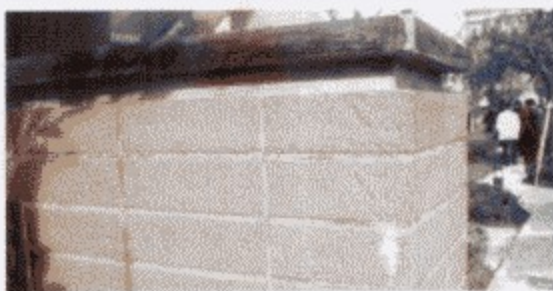
图2-63 预制混凝土砌块墙
