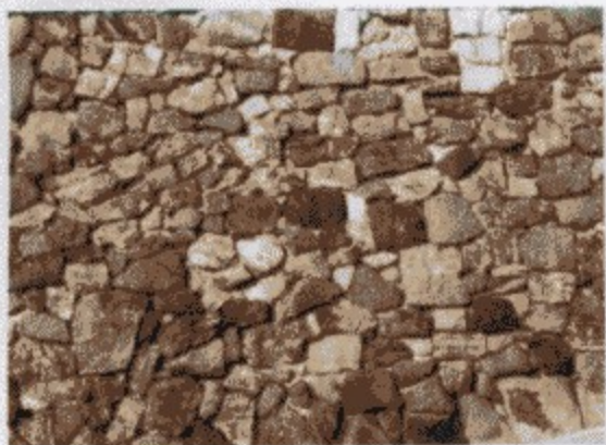
图2-54 锥形石砌挡土墙
