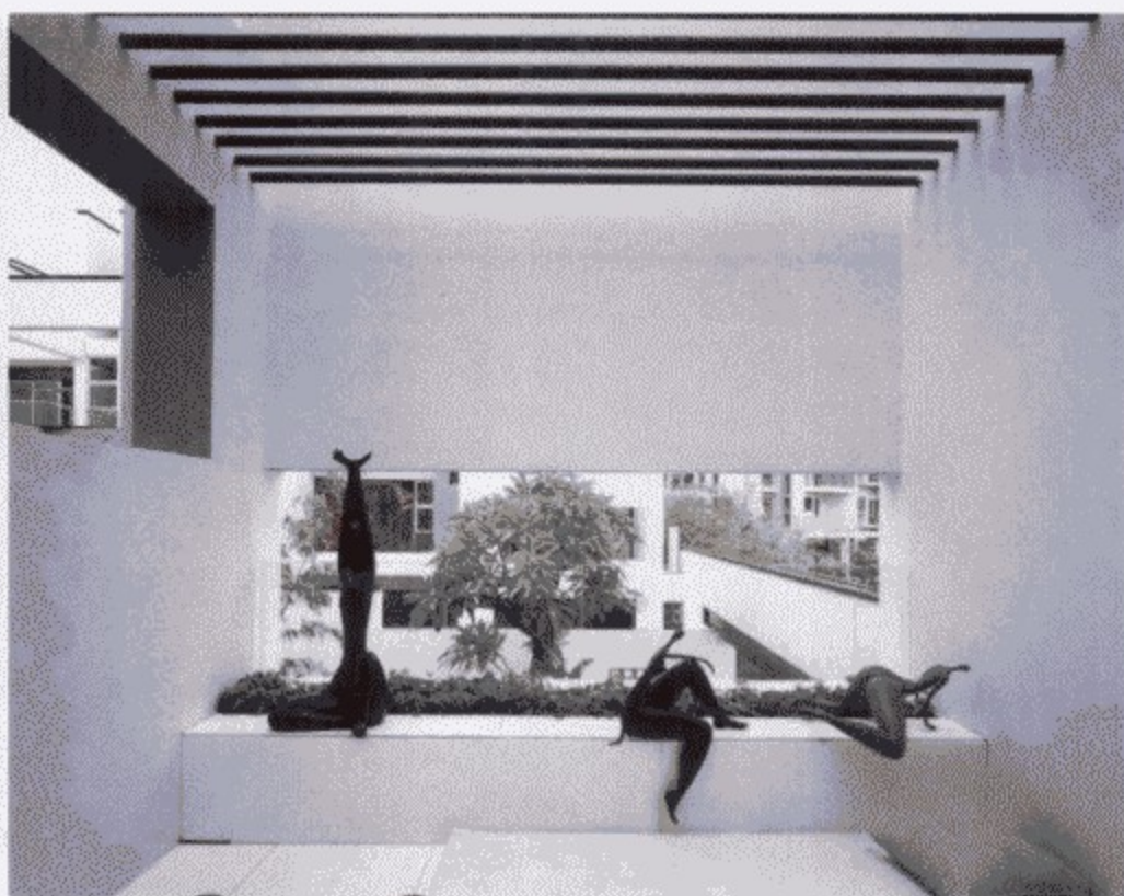
图2-94 钢结构雨阳篷(一)
