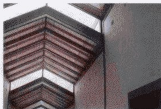
图2-95 钢结构雨阳篷(二)
