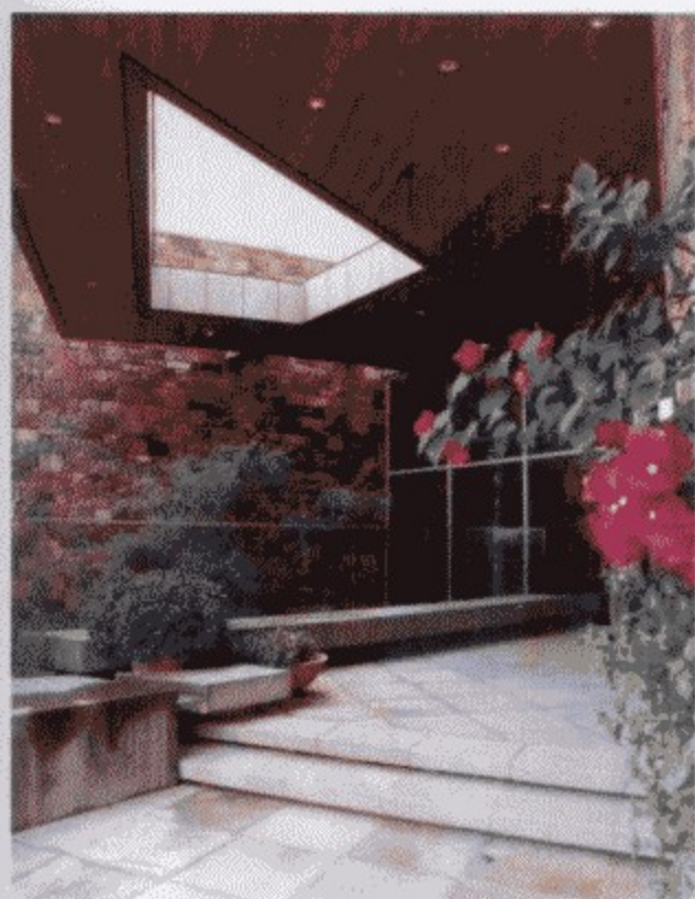
图2-93 混凝土雨阳篷
